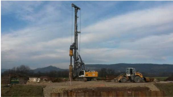
Brückenbauwerk 6.1 am Anschluss Bühl-Bonlanden, Herstellung der Bohrpfähle Widerlager Nord
