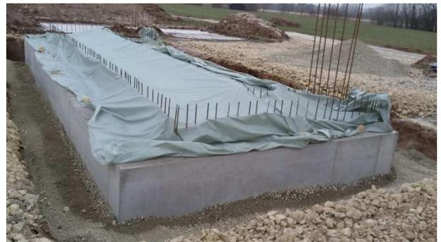
Brückenbauwerk 6.1 am Anschluss Bühl-Bonlanden, Fundament Widerlager Nord
