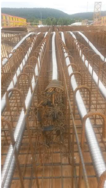
Brückenbauwerk 6.1 am Anschluss Bühler-Bonlanden, Spannglieder
