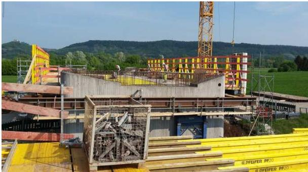
Brückenbauwerk 6.1 am Anschluss Bühler-Bonlanden, Überbauschalung herstellen
