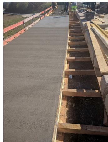
Brückenbauwerk 2.1 Restarbeiten am Knoten Rottenburg/Ost, Betonieren der Kappen
