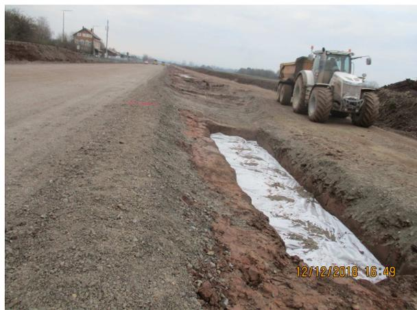
Straßenbauarbeiten am Anschluss Bühl-Bonlanden, Längsentwässerung der B 28 über ein Mulden-Rigolen System
