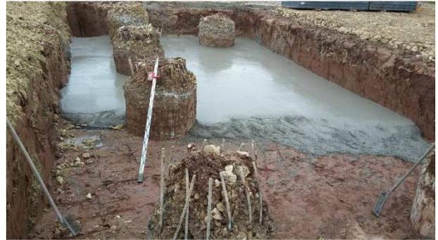
Brückenbauwerk 6.1 am Anschluss Bühl-Bonlanden, Herstellung Fundament Widerlager Nord
