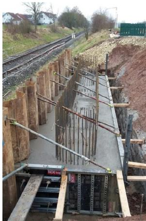
Brückenbauwerk 6.1 am Anschluss Bühl-Bonlanden, Fundament Mittelpfeiler
