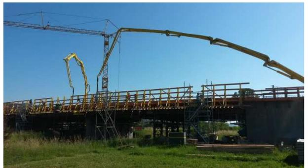
Brückenbauwerk 6.1 am Anschluss Bühler-Bonlanden, Überbau betonieren (Blickrichtung Tübingen)
