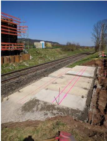
Brückenbauwerk 6.1 am Anschluss Bühler-Bonlanden, Traggerüstfundament
