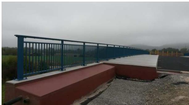
Brückenbauwerk 6.1 am Anschluss Bühl-Bonlanden, Gelände: Beschichten und Endmontage
